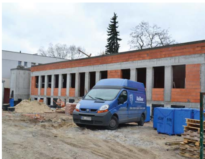
Trwa już rozbudowa przychodni w Falenicy, widok od strony ul. Bambusowej
