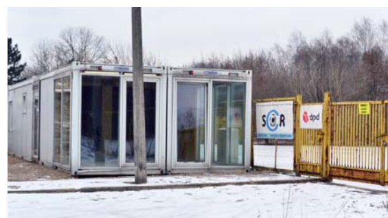
W takich przeszklonych kontenerach będzie zaplecze SCR FOT. AM
