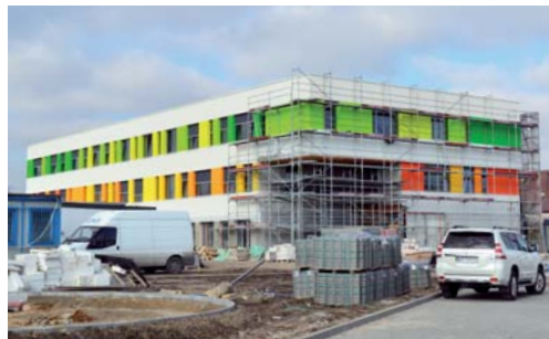
Budynek zespołu żłobkowo-przedszkolnego w Nadwiślu
