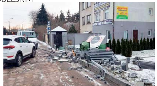
Zrujnowanie ogrodzenia kawiarni i prywatnej posesji FOT. TEL
