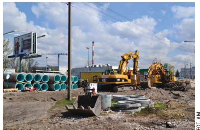
Budowa ostatniego, trzeciego odcinka kolektora W, od którego m.in. zależy będzie skanalizowanie kolejnych fragmentów Wawra
