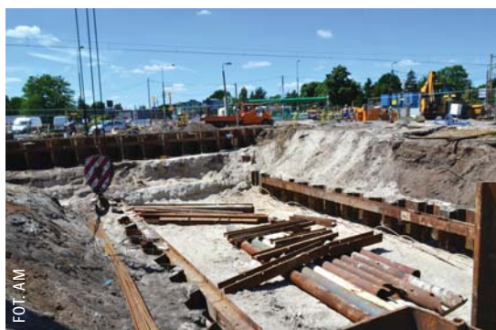
Przygotowania do budowy podziemnego przejścia na perony stacji PKP w Międzyzlesiu
