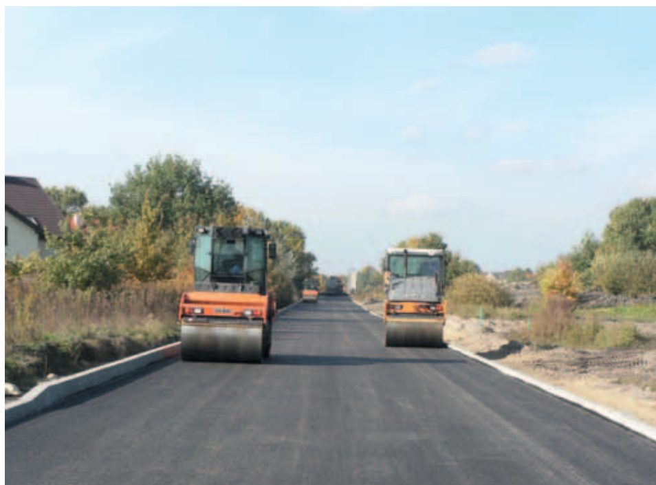
Powstał w tym roku bardzo potrzebny ciąg komunikacyjny – ul. Panny Wodnej od Patriotów po Wał Miedzeszyński
