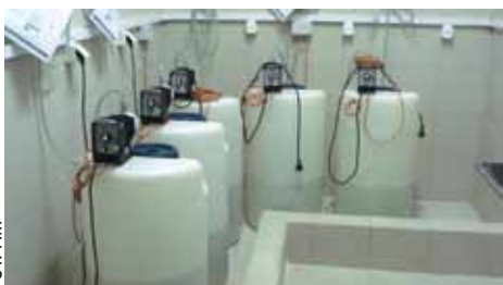
Dokonano przeglądu całego technicznego zaplecza
