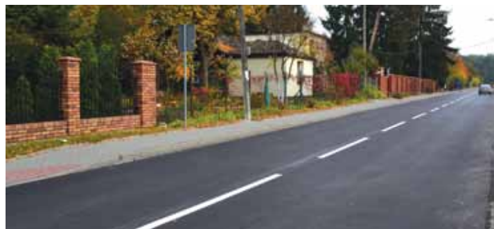
Ulica Ochocza w Falenicy po wykonanym remoncie nawierzchni
