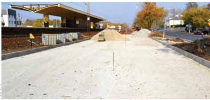
Budowa jednego z trzech nowych parkingów przesiadkowych przy stacjach kolejowych
