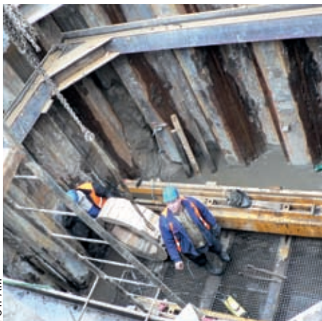
Jeden z nowych szybów startowych dla tarczy drażącej otwór pod kolektor W wzdłuż ul. Zwoleńskiej
