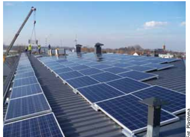
Montaż paneli fotowoltaicznych na jednej z hal wybudowanych przez Plastomę w Zerzeniu przy ul. Cylichowskiej
