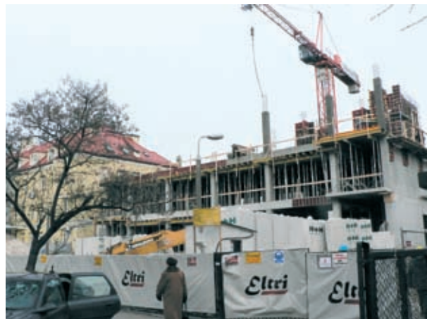
Budowa nowego pawilonu przychodni przy ul. Strusia
