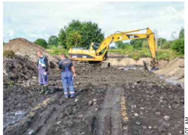
Najbardziej newralgiczne miejsce na budowie ul. Panny Wodnej, po wschodniej stronie Kanału Zagoździańskiego. Podmokłe. Podniesiono na tym odcinku niweletę przyszej jezdni, wykonując mocniejszą podbudowę. Nowym odcinkiem ul. Panny Wodnej oraz przebudowanym starym będzie można przejechać w końcu tego roku
