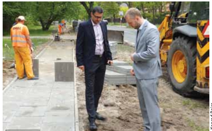
Budowa nowego chodnika wzdłuż ul. Izbickiej, wizytowana przez wiceburmistrza Adama Godusławskiego i dyrektora ZGN Arkadiusza Kuranowskiego
