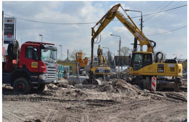
Po dwóch miesiącach już układano rury kolektora W przy stacji benzynowej
